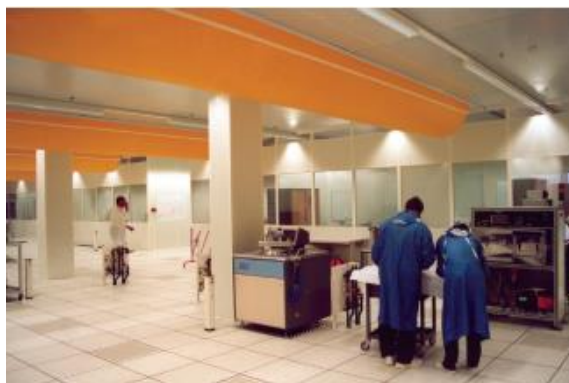
Figure 10 : Gaine textile à gauche - plafond diffusant à droite (Sources France Air et Oxygen web)
