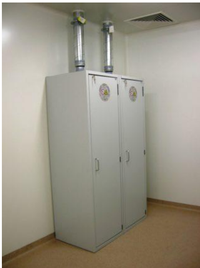
Figure 4 : Armoire de stockage de produits chimiques (Source equipLabo)
